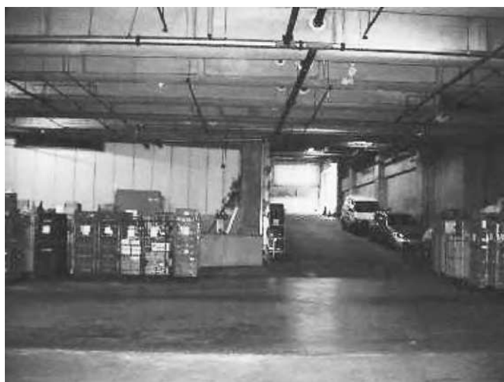
②屋内（地階）に設置した荷さばき施設 荷さばき施設を屋内（地階）に設け、外部への騒音伝搬を防止している。
