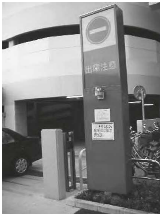
⑥車出入口 グレーチングと出庫表示灯(消音)
