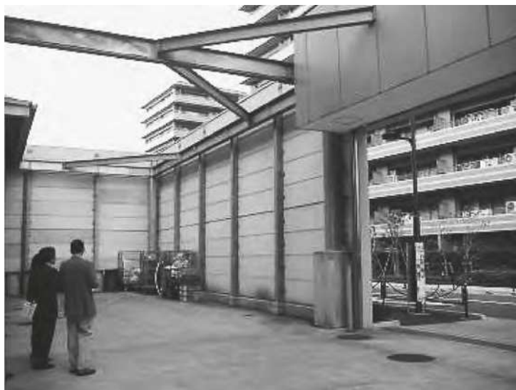
②トラックヤード 防音壁、シャッター
