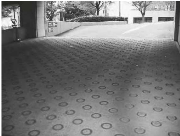
④地下駐車場へのスロープの騒音対策 駐車場のスロープ部分はコンクリート舗装部分に滑り止め対策を講じ、走行車両のタイヤから発生する騒音（タイヤの横すべりによる きし 軋み音）を低減している（特にカーブ部分）。
