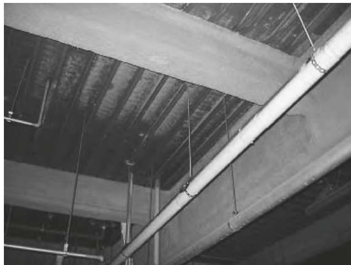
⑧地下駐車場天井部分の騒音対策
