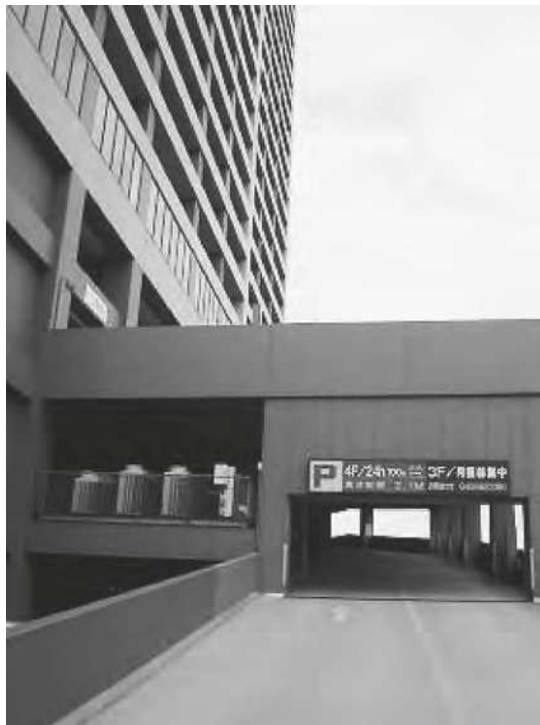
④駐車場の屋内配置 駐車場はスロープを設けることにより、建物の3階・4階部分に設置し、屋内化している。
