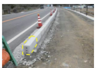
図表 10. CO 2 吸収型コンクリートの使用例（出典 10）
