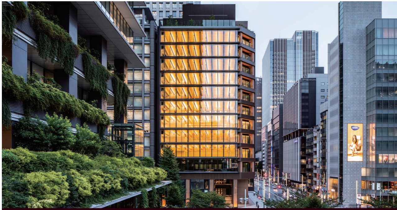
東京駅に近く、再開発に挟まれた京橋交差点に建つ。3~12階にテラスを2か所設け、テナント入居者の専有部とした。南側コーナー部のテラスは、角を切った平面図形状とし、木柱・木梁で構成した。本建築を含め、交差点の4角に建つ建物は、第一生命グループが所有している。(一部共有を含む)
