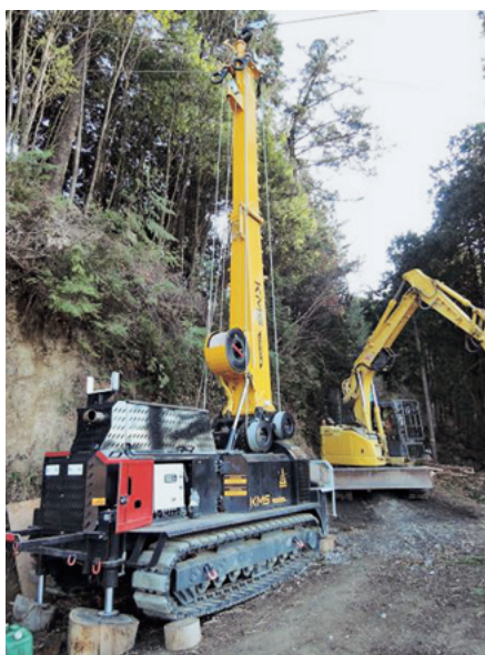
タワーヤーダ(日の出町)
