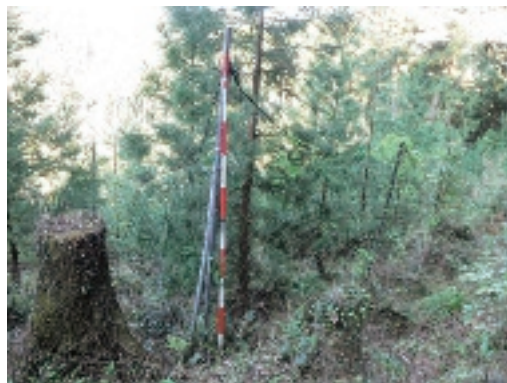
写真－2 撤去前状況
