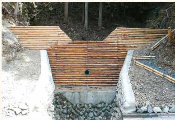
盆堀沢治山工事 木製残存型枠、筋工
