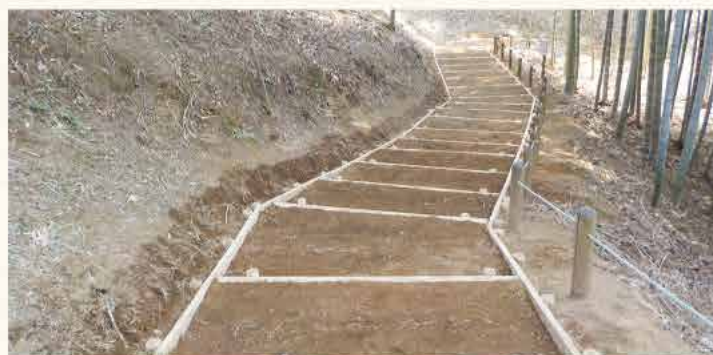
小山田緑地 木製階段補修
