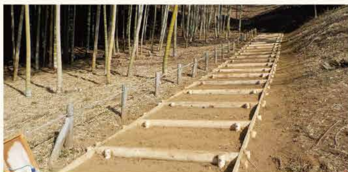
小山田緑地 木製階段補修
