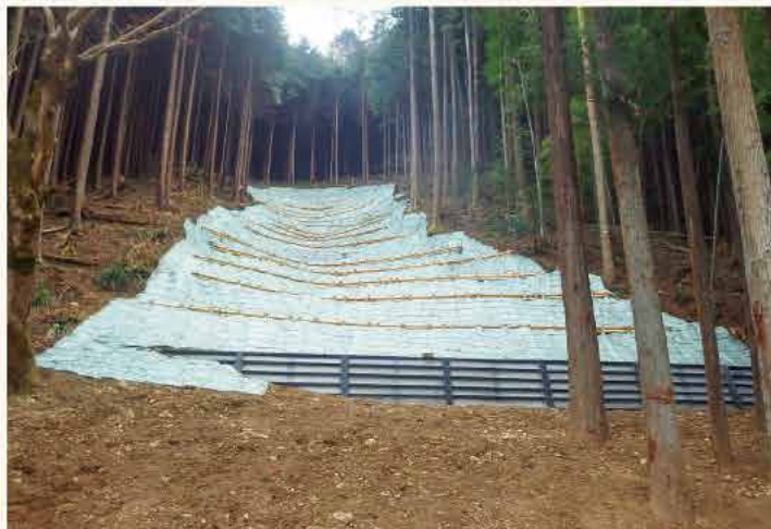
上恩方治山施設災害復旧工事 筋工
