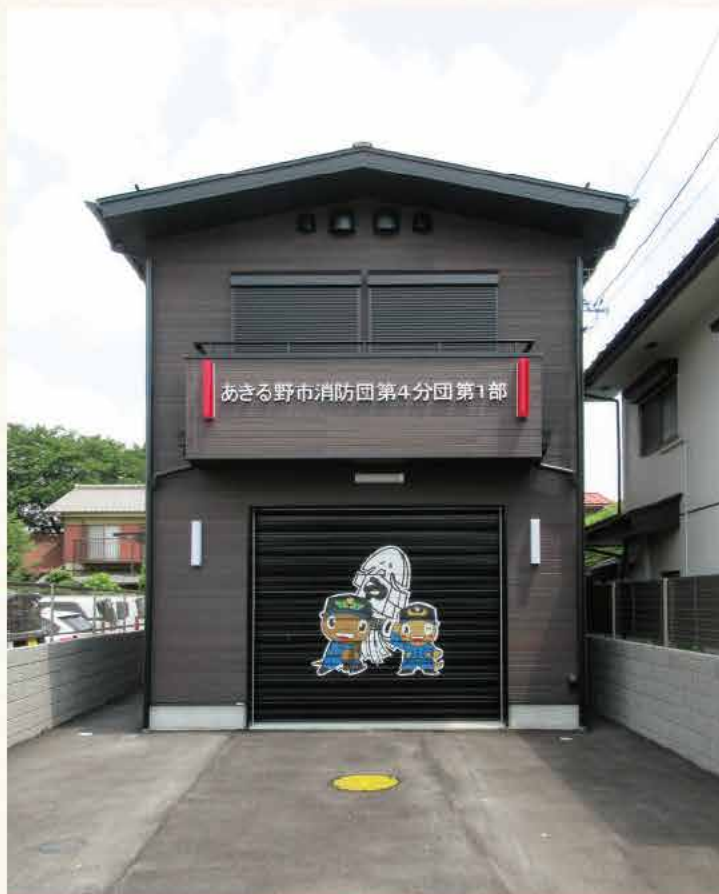
あきる野市 消防団詰所新築工事 構造材・仕上材
