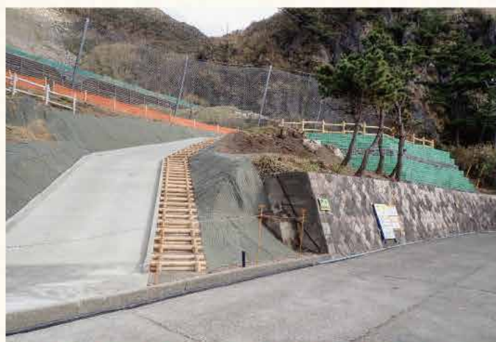
大島支庁 神戸山（治山事業）階段、転落防止柵
