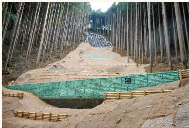
長畑治山工事 柵工、筋工
