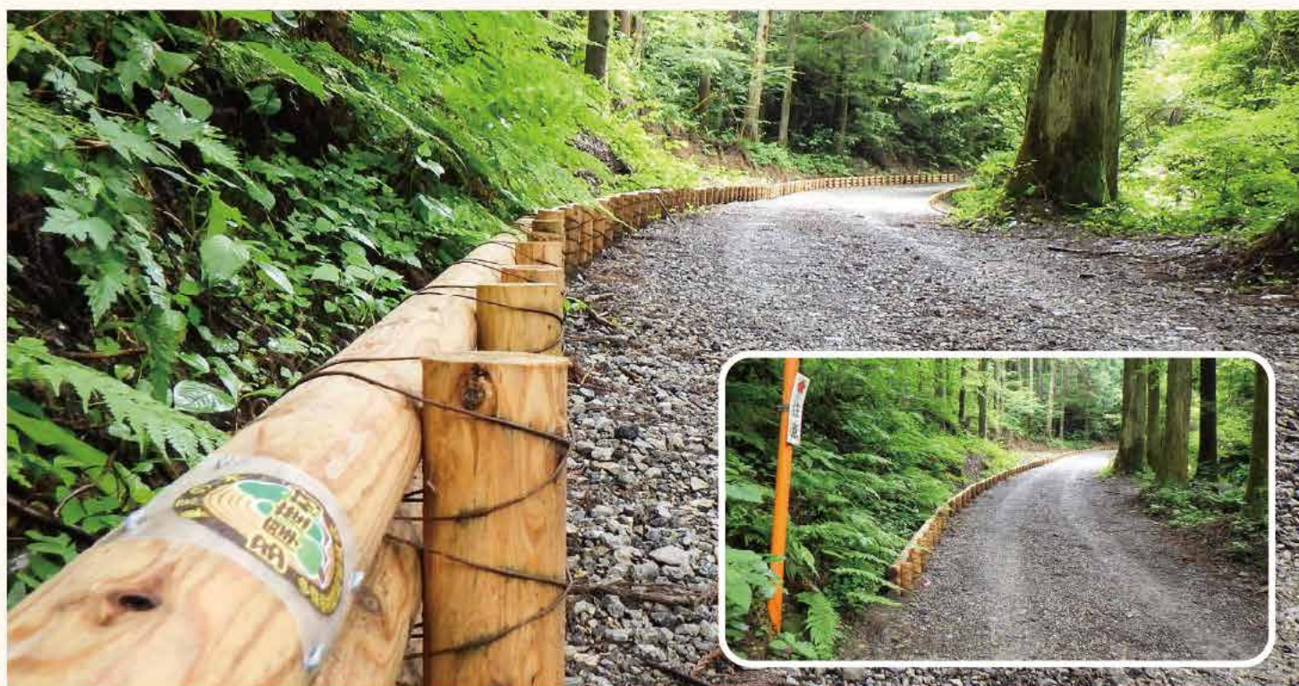
日影林道 木柵工
