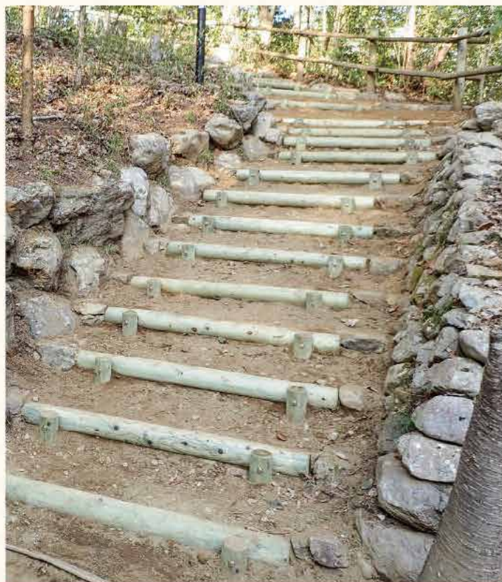
あきる野市 土木工事 階段、土留め柵等
