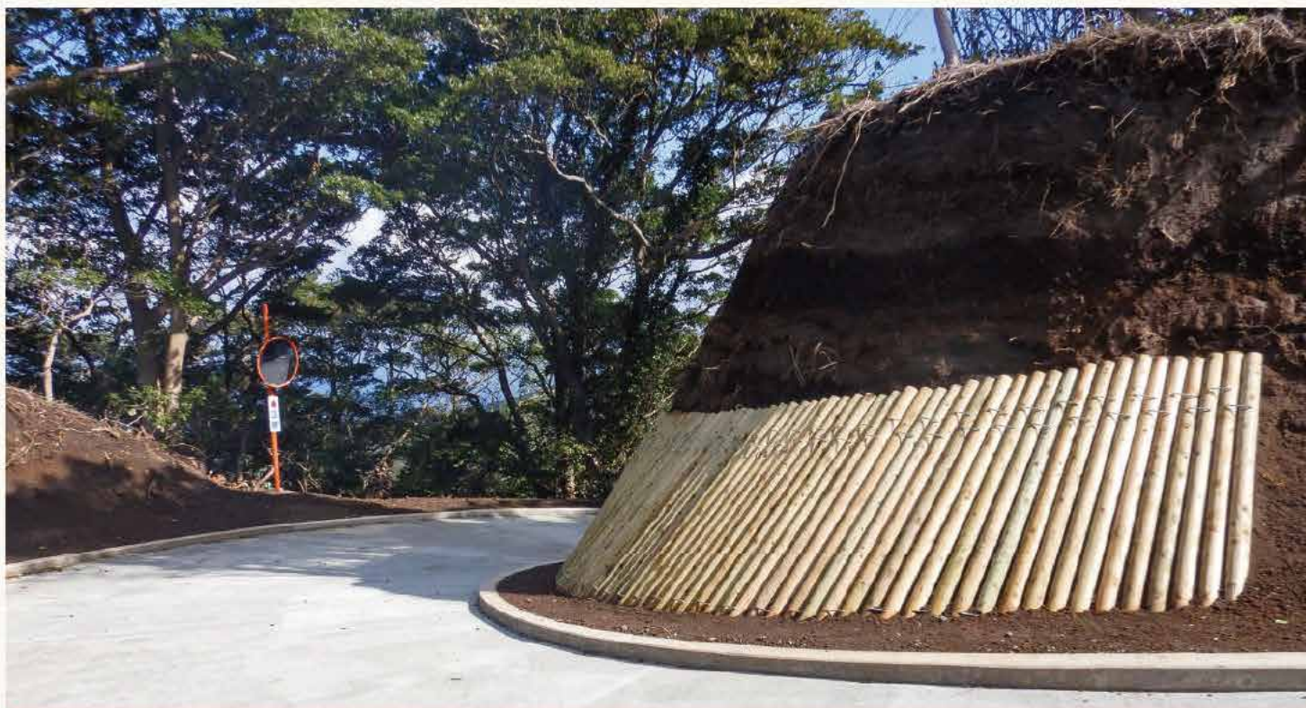
三宅支庁 伊ヶ谷林道災害復旧工事丸太伏工
