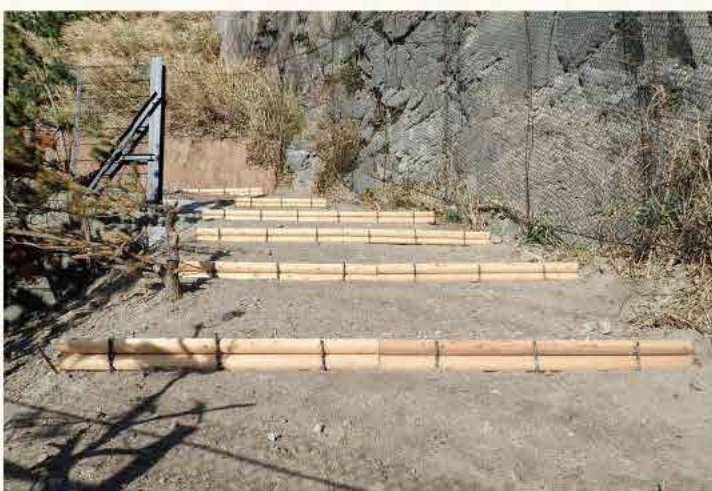
大島支庁 高嶺（治山事業）筋工
