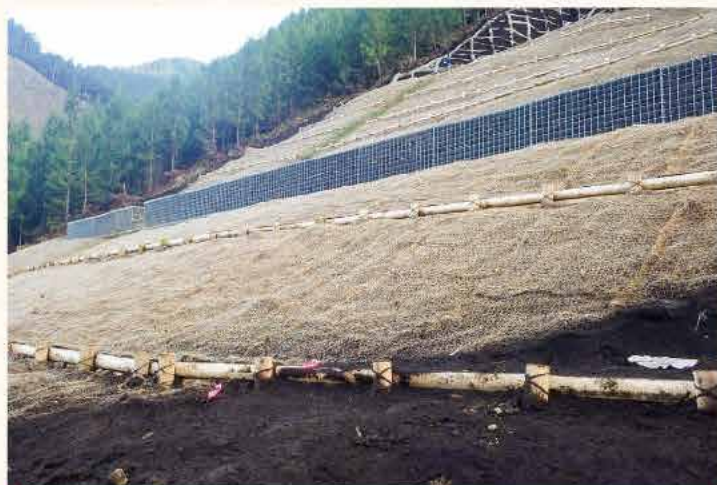
御岳林地荒廃復旧工事 筋工
