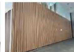
木製ルーバーを設置
