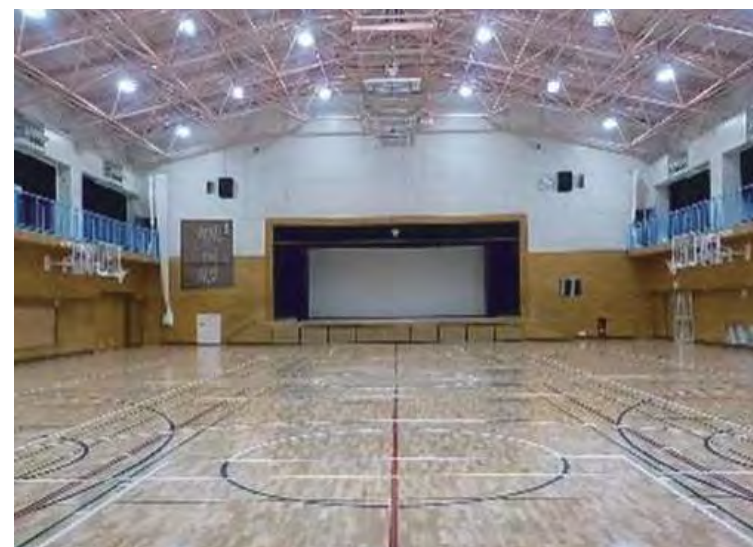
第三中学校第一体育館改修工事
