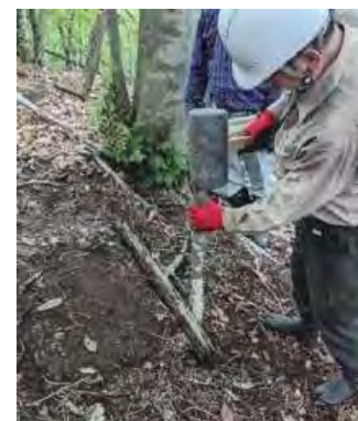
階段補修の様子
