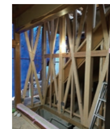
②既存建物を分析し耐震補強工事を実施
