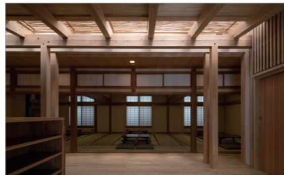
寺務所：既存部と増築部の境目のトップライトから"渡りあご掛け"の連続梁を通り抜け、建物中央部に自然光が降りそぐ
