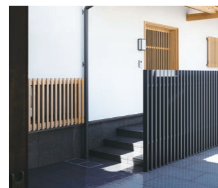
縦格子ピッチをそろえることで敷地内の他の建物との調和を図る
