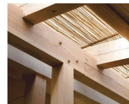
既存部と増築部の境目には、エキスパンションジョイント機能を備えたトップライトを考案し、手刻みの伝統的な仕口継手に光が集まるシーンを演出した
