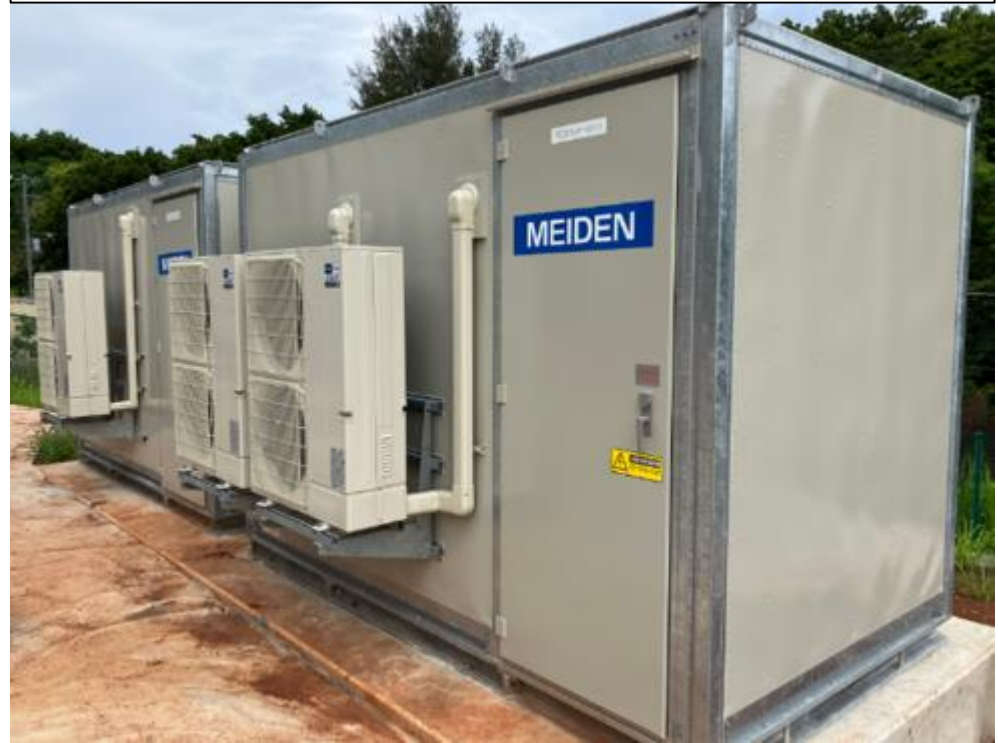
設備へ低反射性の塗料を塗布
