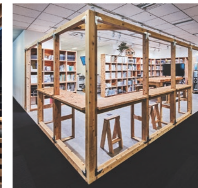
技術者が建材サンプルを確認する場（LABO）。構造材を活用してフレームやシェルフ・カウンターを設計
