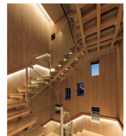
階段：手摺・踏板はLVL/蹴上・ササラを75角ヒノキ材で木質化
