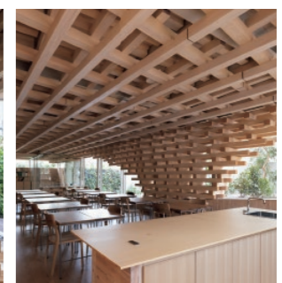
造作家具：ディスプレイ棚や書庫・可動棚はLVLの角材・ボードで作り、キッチンカウンターは天板をヒノキ材、側板をCLTとした。
