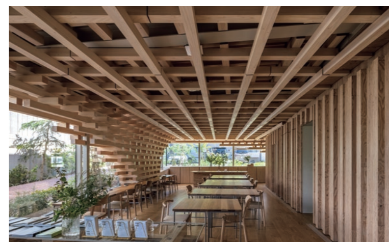
B1階：木組積壁とLVL角材の壁・フローリング・アロマコリドールの植栽と多種多様な木に囲まれたイベントスペース
