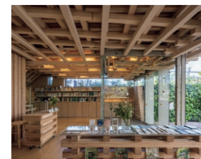
造作家具：ディスプレイ棚や書庫・可動棚はLVLの角材・ボードで作り、キッチンカウンターは天板をヒノキ材、側板をCLTとした。
