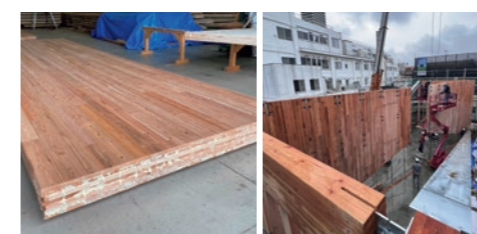
CLTのマザーボードと建て方の様子
