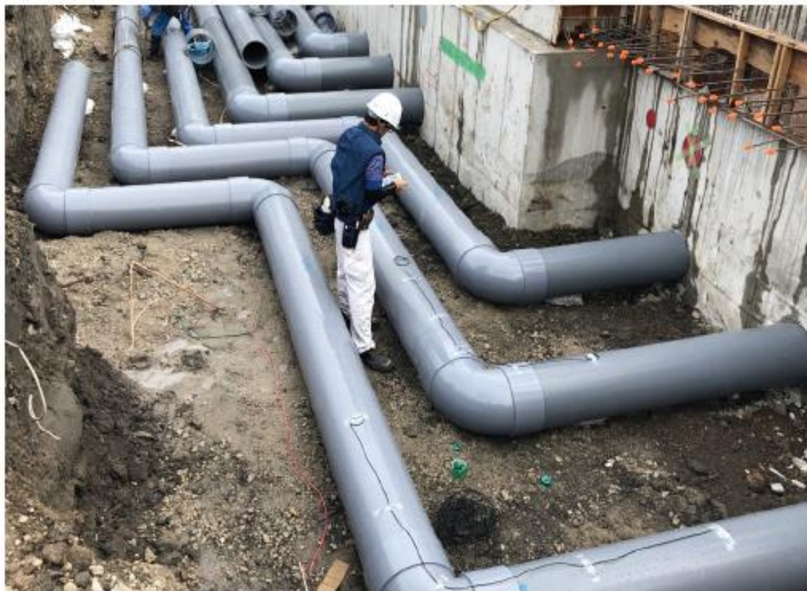
アースチューブ施工状況
