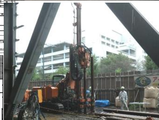
地中熱交換器設置
