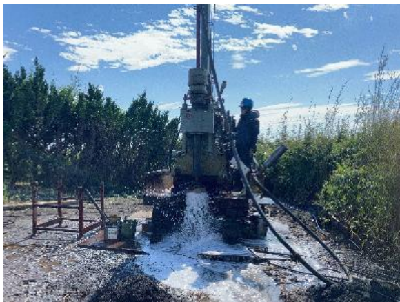
小型のボーリングマシンによる 地中熱交換器設置工事
