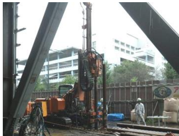
機械ボーリング全景 (ボーリングマシン2台による施工状況)
