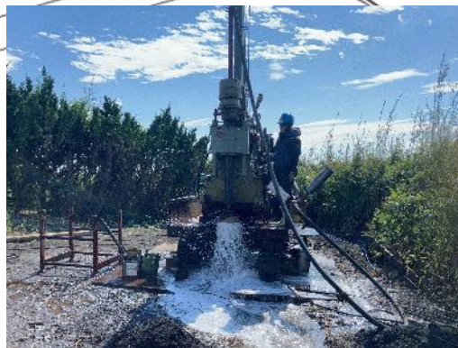
地中熱交換器設置
