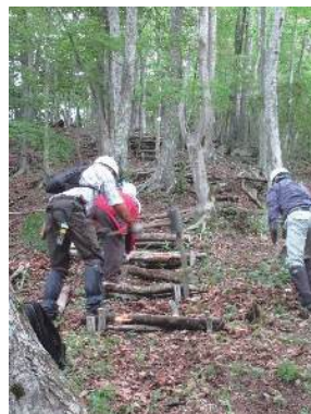
階段補修の様子
