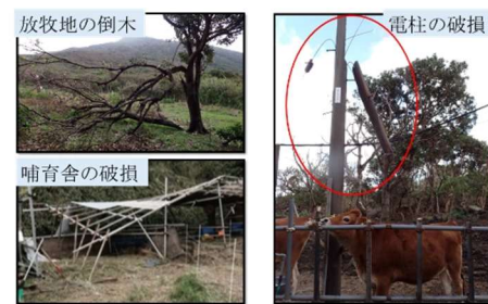
図3 B酪農場の被害状況
