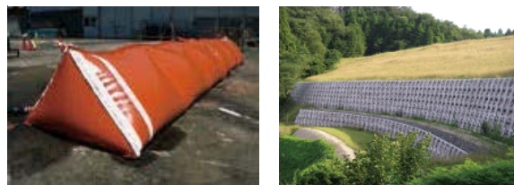
図表 6 可搬式堤防(左)と「ブランチブロック工法」により復旧された擁壁(右)(出典 6、7)
