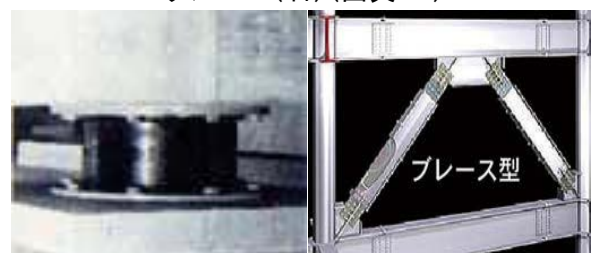
図表 12 耐震強化に使われるゴム(左)とダンパー(右)(出典 14)
