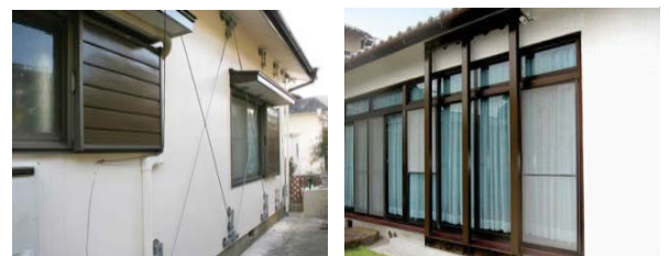
図表 14 「ウッドピタ工法」による耐震化事例（出典 16）
