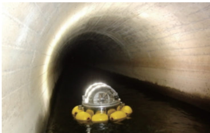
水路内撮影状況
