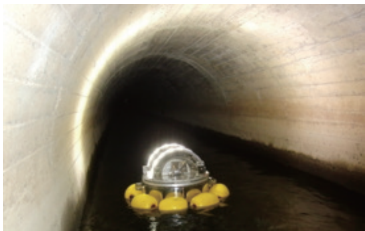
水路内撮影状況
