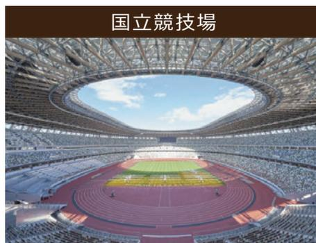
大屋根のトラスには木材と鉄骨を組み合わせた部材を使用し、全ての観客席から木のぬくもりが感じられるようになっています。また、建物の外周の軒庇や室内にも積極的に木材を利用しています。
