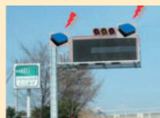
道路付帯構造物傾斜センサ
