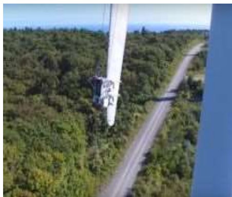
【H28新市場創出型】 既設大型風力発電機の ブレードの点検／塗装の自動化
