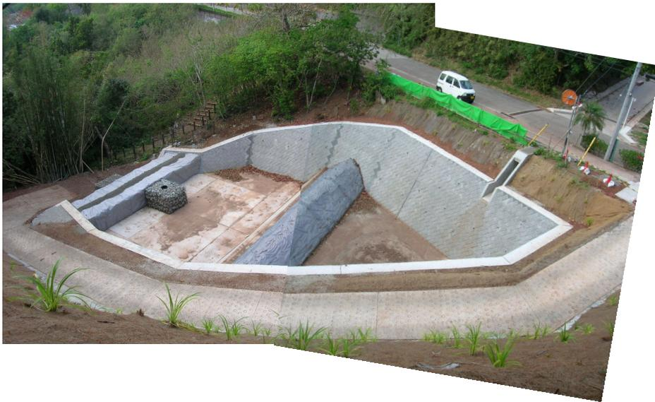
貯水量は約300tで傾斜地に2段の水槽構造となっており、各段の下流部分に“ろ過施設”を設け、赤水をろ過する構造となっています。
