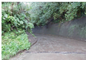
事業2：土砂撤去
