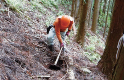
事業2：林内歩道改修の様子
