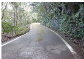
事業1：草刈側溝清掃
