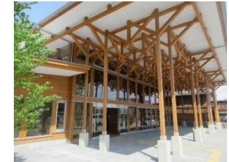
あきる野市 木造施設の整備
