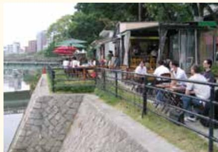
1 従来型であるコンクリートの直立堤防と違い、盛土により構成される幅の広い堤防で、高潮や大地震に対して安全だけでなく、水辺環境の向上が図れる堤防
