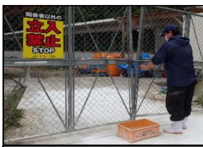
フェンスなどの設置
