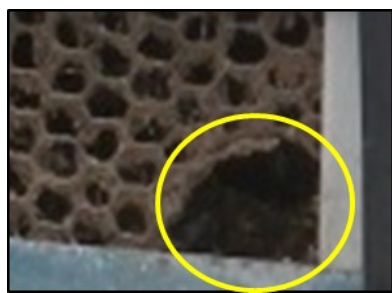
金網などの破損修繕
