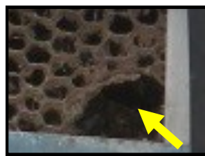
破損箇所の修繕
