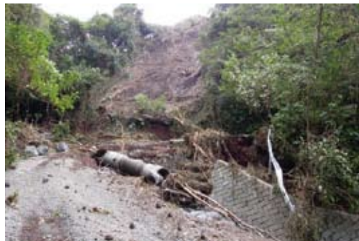
〈斜面崩壊により林道が被災〉
