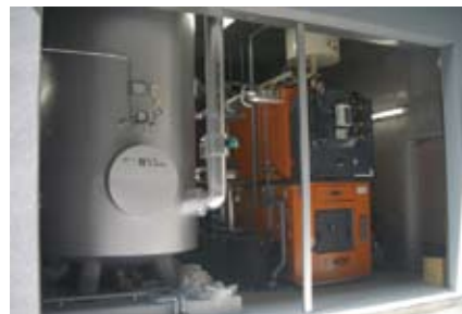
〈貯湯タンク（左）と 300kW のチップボイラー〉
