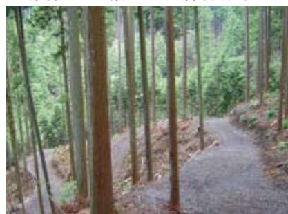
〈高密度に整備された森林作業道〉
