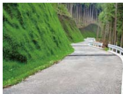
〈壁面が緑化された林道〉
