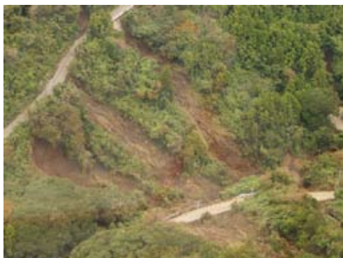
〈町道の下部に大規模な斜面崩壊が発生〉
