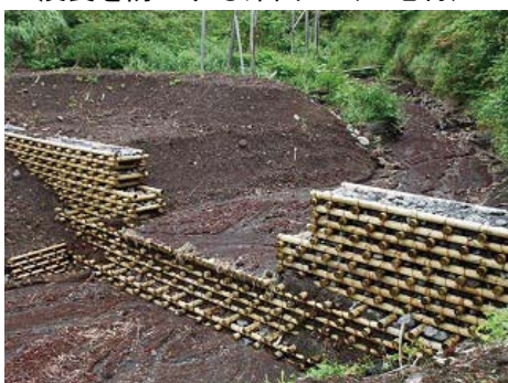
浸食を防止する床固工（三宅村）
