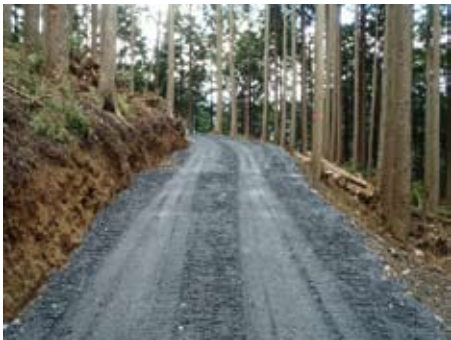
〈整備された森林作業道〉
