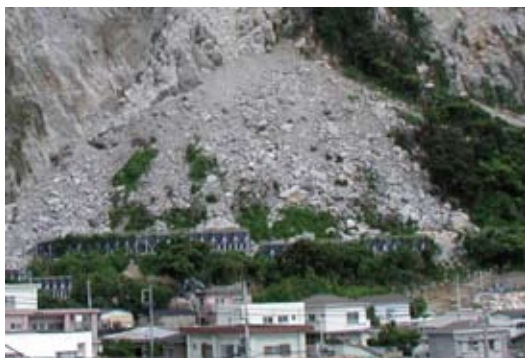
人家近くの落石防護壁工（新島）
