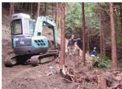
〈森林作業道の開設〉
