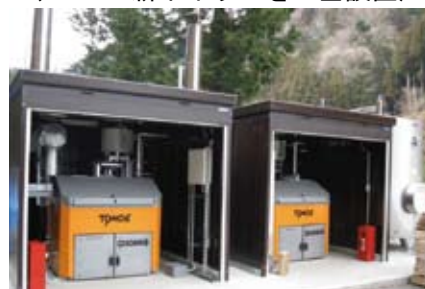
〈80kW の薪ボイラーを 2 基設置〉
