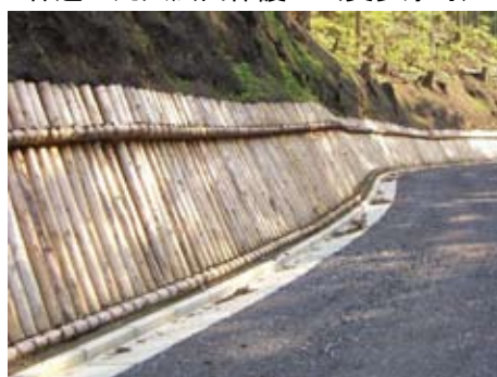
林道の丸太法面保護工（奥多摩町）
