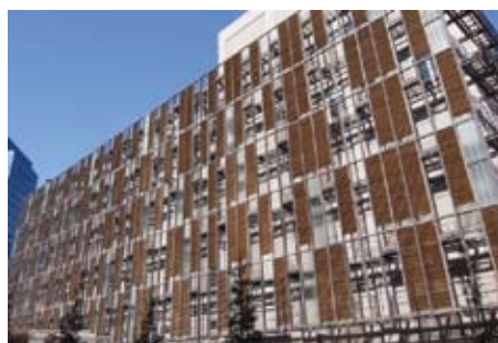
〈都立産業技術研究センターのルーバー〉
