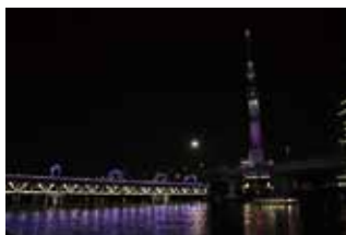
隅田川橋梁（東武鉄道）
