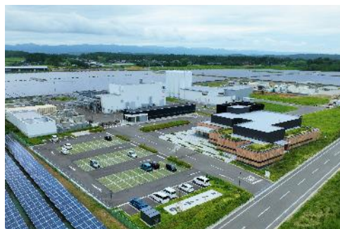
福島県産グリーン水素の製造施設 福島水素エネルギー研究フィールド (FH2R) (出典：NEDO)
