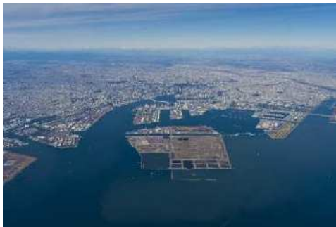
埋め立ての進んだ現在の東京湾
