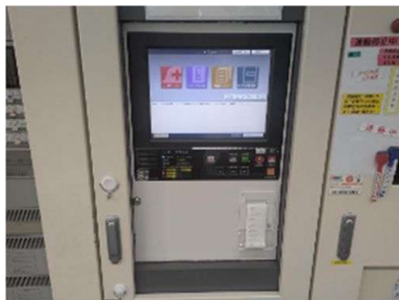
本部 自動火災報知設備更新工事
