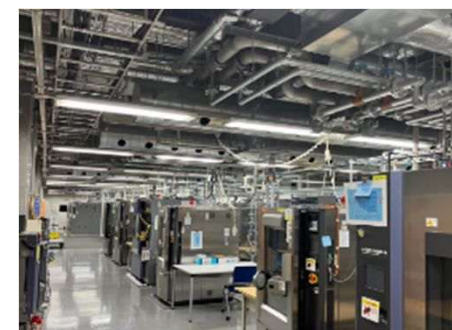
本部 照明設備改修工事
