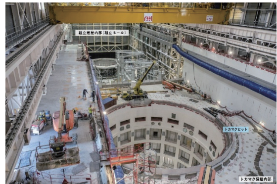
図表 49. 核融合実験炉「ITER」の建屋内部の様子 (2020 年時点) (出典 6)
