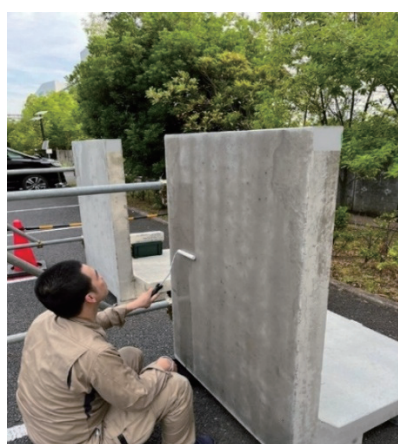
図表50. 塗るだけでコンクリートのCO 2 固定化を促進する塗料 (出典7)
