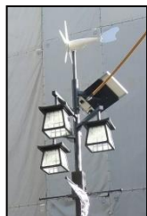
(太陽光・風力発電システムを備えた街路灯)
