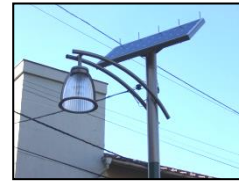
(太陽光発電システムを備えた街路灯)
