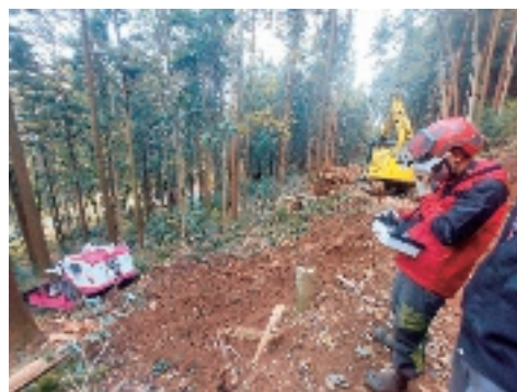
写真-10 シン・ラプトルⅡ遠隔操作
