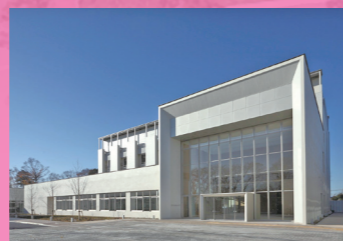
テクノプラザ本館
