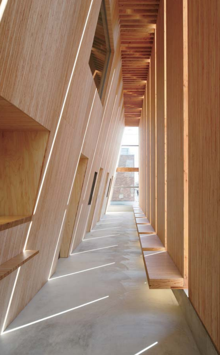
待合室内観 1時間準耐火構造の木層ウォールLVL積層面をあらわして用いている
