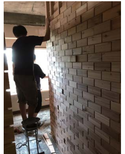
小さな木材を積上げる施工
