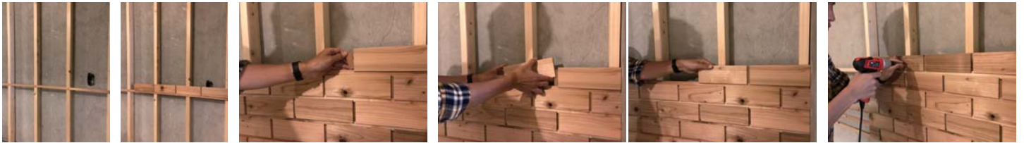
①間柱に横帯を留める ②横帯に横み上げる ③縦帯で繋げる ④横帯、縦帯を小さな木材の突(さね)にはめ込む ⑤1段おき、600mmピッチでビス止め
