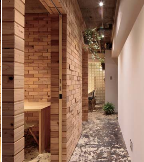
①間柱に横帯を留める ②横帯に横み上げる ③縦帯で繋げる ④横帯、縦帯を小さな木材の突(さね)にはめ込む ⑤1段おき、600mmピッチでビス止め
