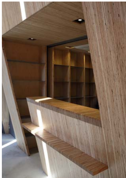
待合室受付 診察室側は壁区画のため強化石膏ボードの上にLVL仕上材貼り
