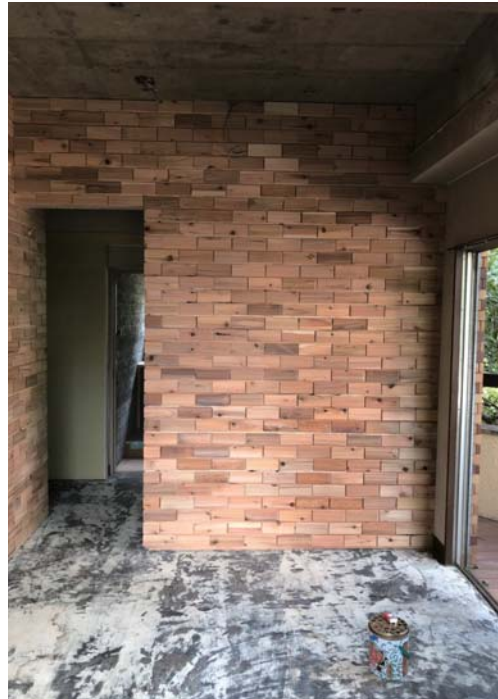
各シェアオフィスを区切る壁面は小さな木材を木下地の上に積み上げて構成
