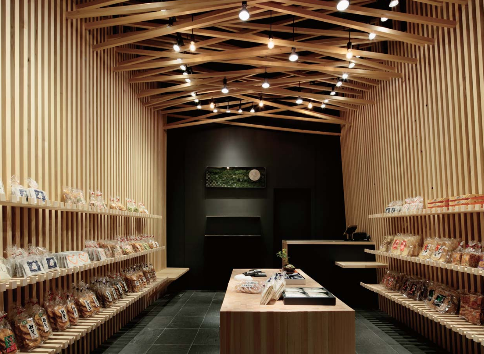
30×40の規格材のみで構成された店舗空間。ルーバーが室内を包み込む
