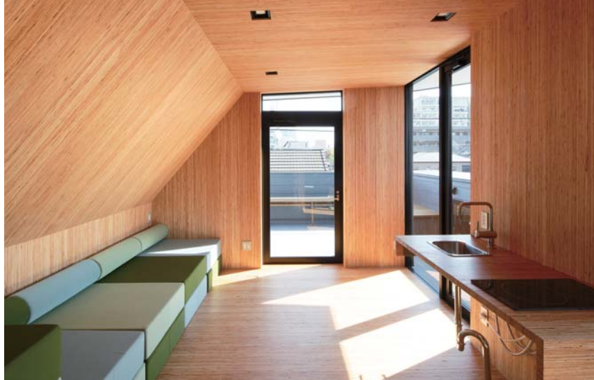
3階医局サロン LVL仕上材を床・壁・天井に使用
