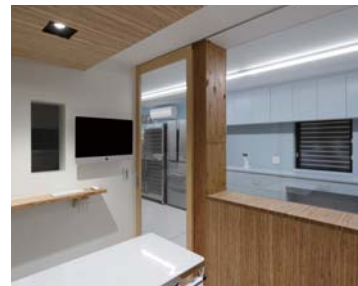
1階診察室 LVLの壁柱があらわとなっている
