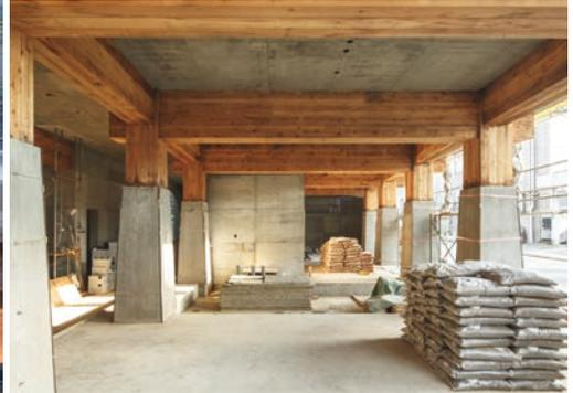
1階の構造体。高さ2mの独立基礎に木の柱が載る。床はRC造。打設計画に工夫を要した。
