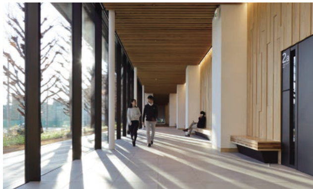
1F ホワイエ 凹凸のあるヒノキ壁・CLT ベンチ・スギ天井ルーバー
