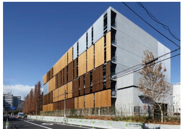
宿泊棟 外装ヒノキ無垢材ルーバー
