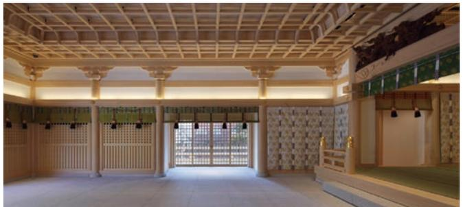
拝殿。柱や天井には吉野ヒノキを用いた。格子の交点のピンスポット照明や天井スリットによる排煙口などの「見せない」ディテールが、伝統建築の純粋性を支えている。 撮影者：古川泰造
