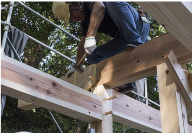
接合部には金物を使わず伝統的な木組みの構法で部材を繋ぐ 撮影：齋部 功
