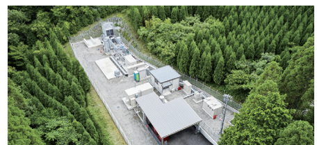
グリーン水素製造実証プラント
