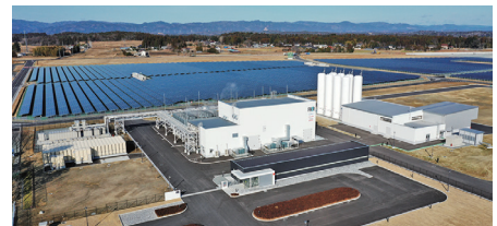
水素製造研究施設
