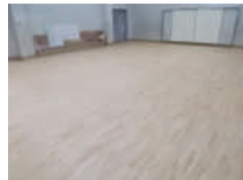
事業1:集会施設の床改修
