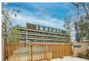
池袋第一小学校 新校舎全景
