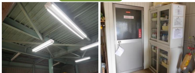
⑥照明の飛散防止設備の整備 (飛散防止タイプの蛍光灯に変更)
