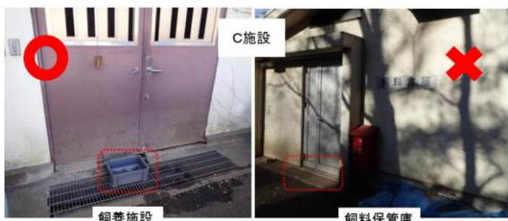
図3 踏込消毒槽の設置状況
