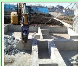
基礎等の解体
