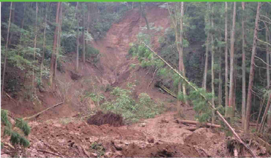
令和元年台風19号被害
