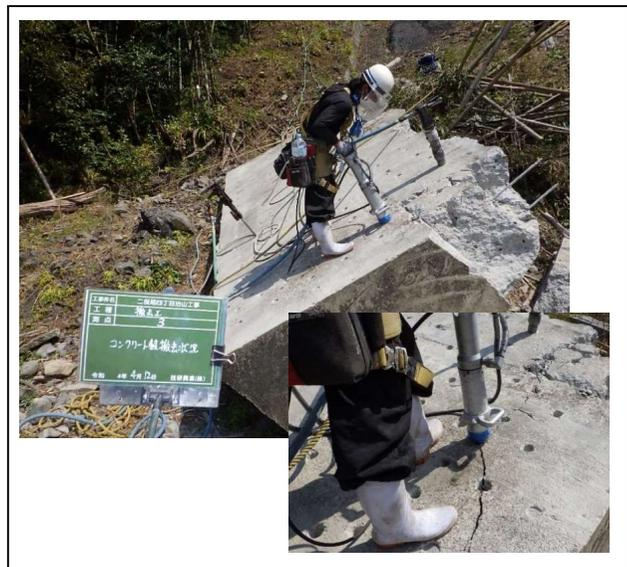
低振動 低騒音 低粉塵による撤去状況写真
