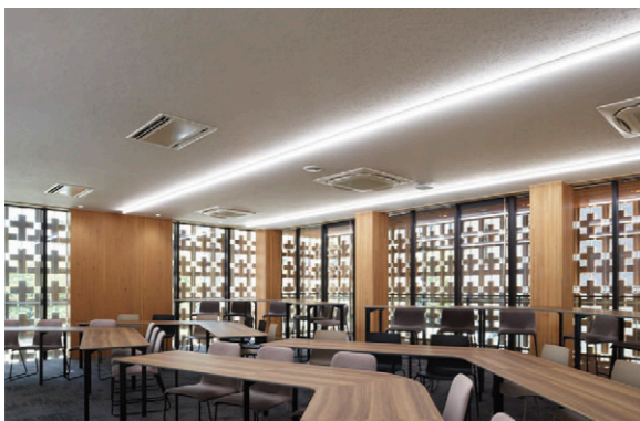
2階教室 右側に当社オリジナルの純木質耐火集成材「木ぐるみFR」による柱、柱は450mm角 (構造要素: 330mm角 + 難燃処理部: 50mm + 仕上げ材: スギ10mm)でスパンは3,450mm
