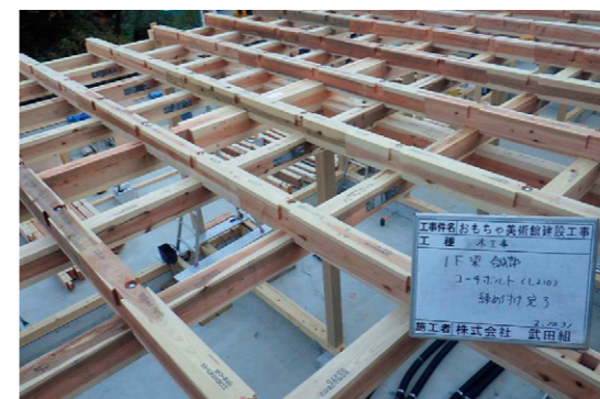
梁工事写真。梁を井桁状に3層重ねる事で、梁成を300mm以下とし、無垢材での材料調達を可能とした。
