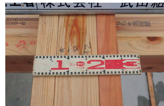
合成梁 中央の梁に別の木材を沿わせて取り付けられている
