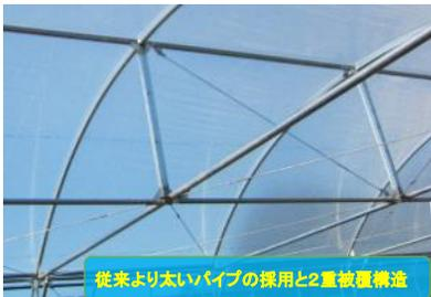
従来より太いパイプの採用と2重被覆構造
